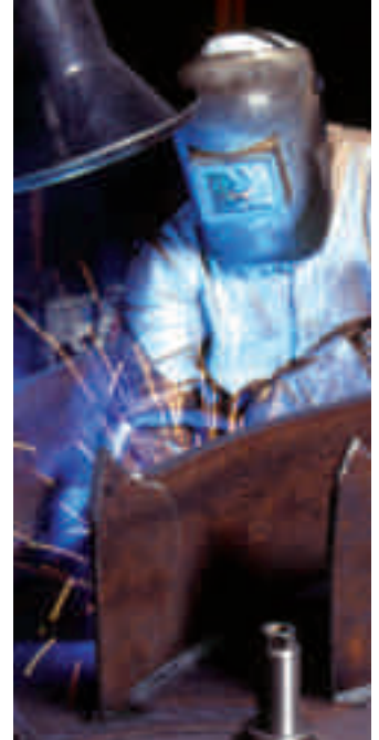
Сварочные работы на ремонтируемой крыльчатке
