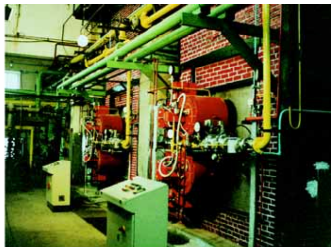
Горелки мод. PYR 5 GN RAC (6.140 кВт)
