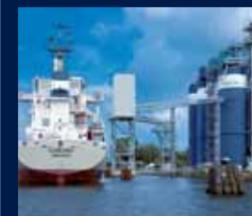
Установки для загрузки и разгрузки судов, перевозящих сыпучие материалы.
