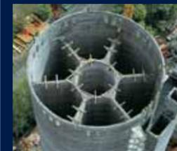
Многокамерные силосы – для хранения различных компонентов, со встроенным смесителем для производства специальных цементов.
